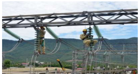
Trạm biến áp 250MVA
